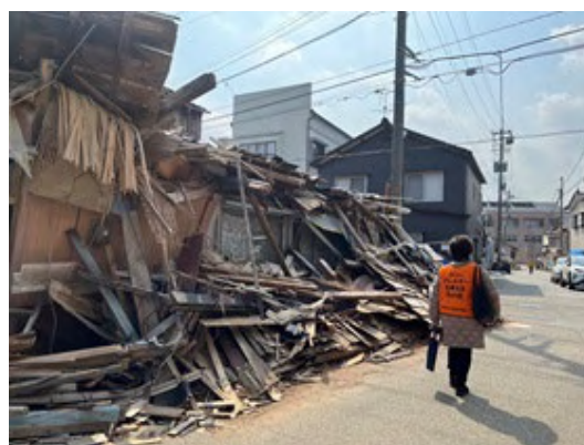
各地で建物は倒壊したままの状態（3 月 15 日 輪島市）
