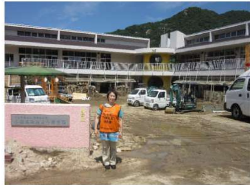
小屋浦地区「みみょう保育園」（8月7日）
