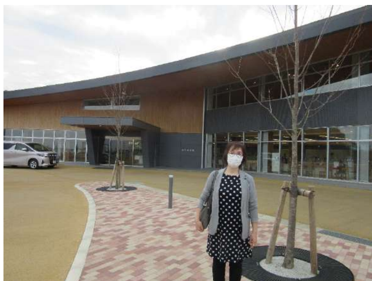
福島県大熊町役場 令和2年11月6日
